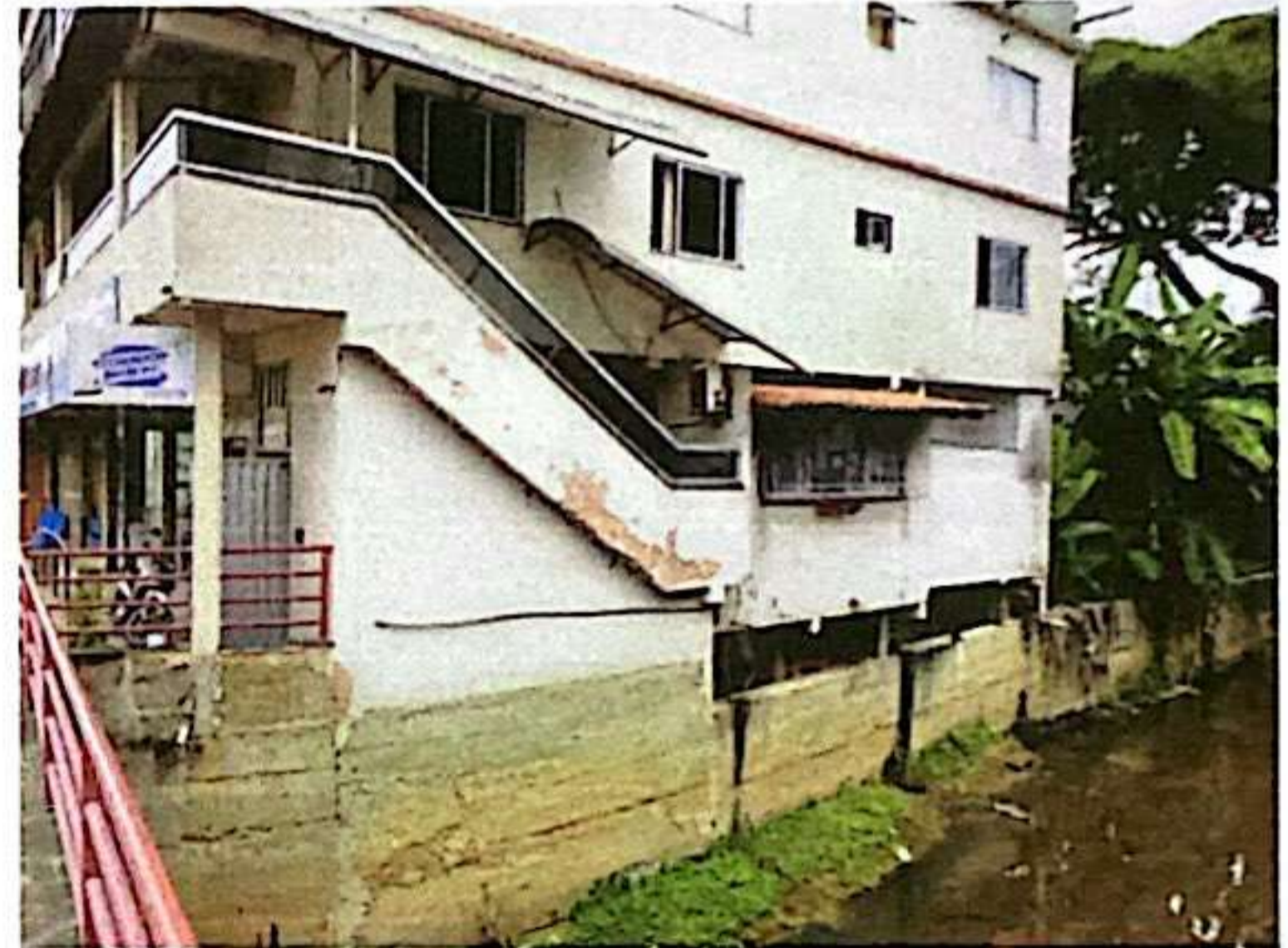
Lateral fronteira com o córrego.
