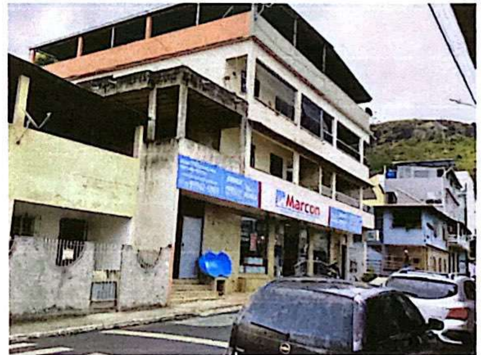
Edificação fronteira lateral oposta ao córrego.
